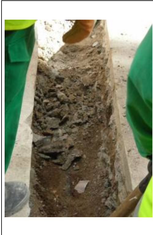
Foto núm.6 Estat final de la rasa al tram central
