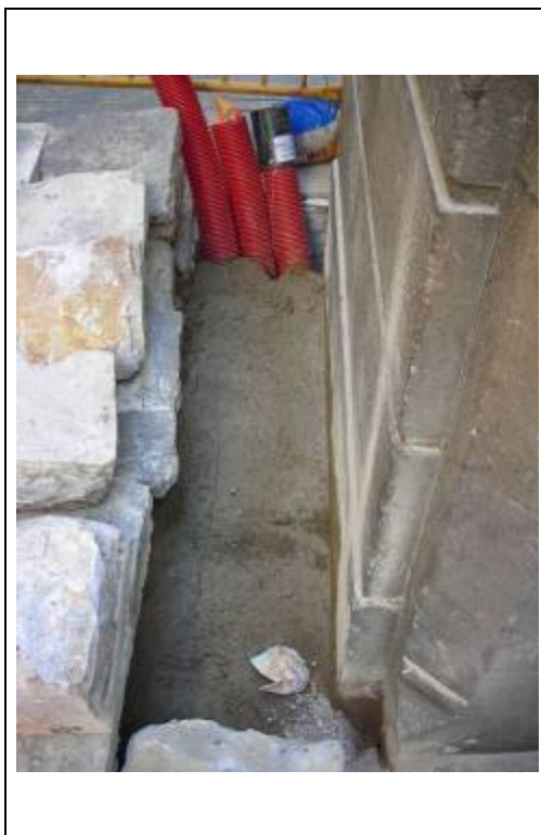
Foto núm.7 Rasa un cop col·locats els tubs de fibra òptica
