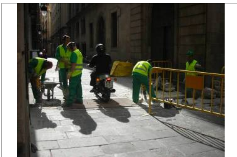
Foto núm.4 Treballs al tram central del carrer Ciutat
