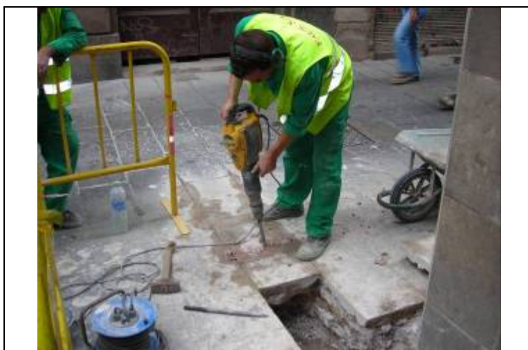
Foto núm.2 Inici dels treballs, aixecament del paviment
