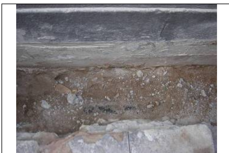
Foto núm.5 Estat final de la rasa amb tub de canalització d'aigua
