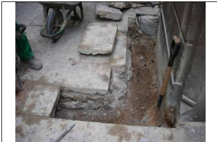
Foto núm.3 Treballs al tram paral·lel a l'edifici de l'Ajuntament
