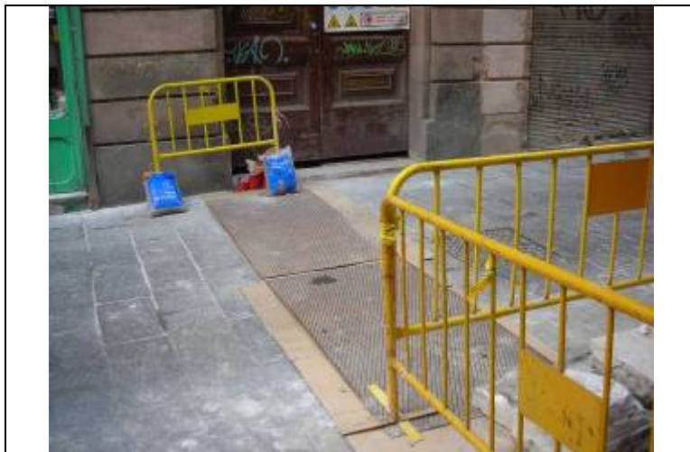
Foto núm.8 Rasa al tram central un cop col·locats els tubs de fibra òptica
